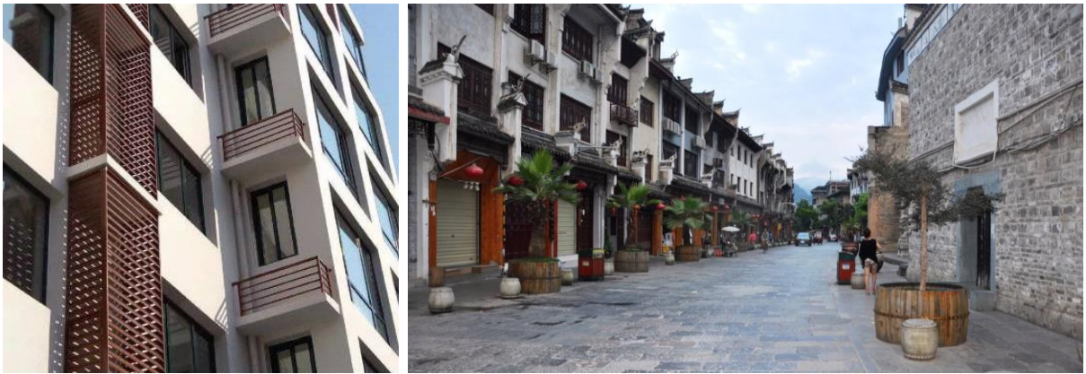
采用百叶护栏遮挡美化空调外机
